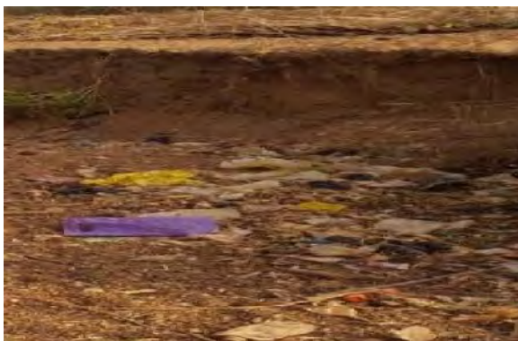
Figure 4: Slumping Site 3 (Stable Site), Latitude 9° 46' 55'' Longitude 6° 8' 30''
